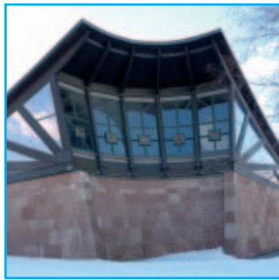
Lato esterno a nord ovest della chiesa
